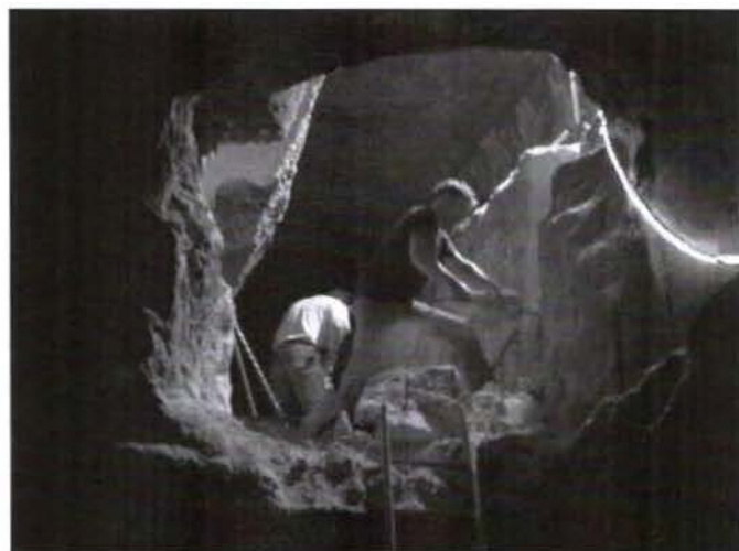
Div werken afsluiten. Het gat waar de stalen poort komt wordt voorbereidt
