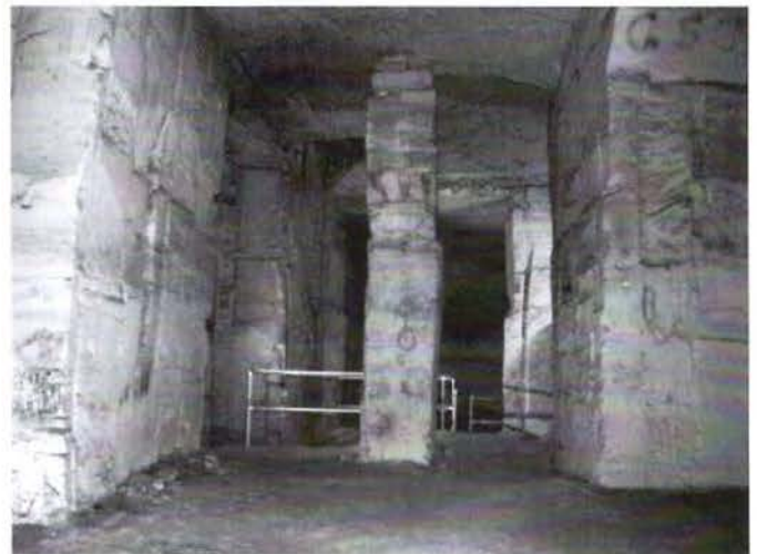
Dunne pilaar. Het onderste gedeelte is monolithisch, het bovenste gedeelte is bijgebouwd met jaartallen vanaf 1863.
